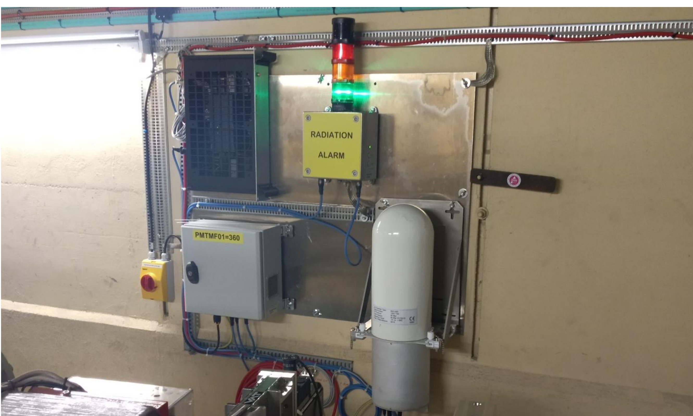
Abbildung 1: Strahlungsüberwachungssystem CROME am CERN. [Abbildung: © CERN]
